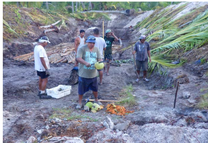
▼ Travaux de réhabilitation d'un vestige de maïte.
